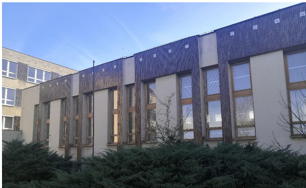
Obrázek 8 – Severní fasáda – tělocvična (opadávající kabřincový obklad)
